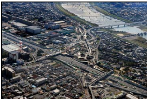
写真②: 京葉JCT付近
