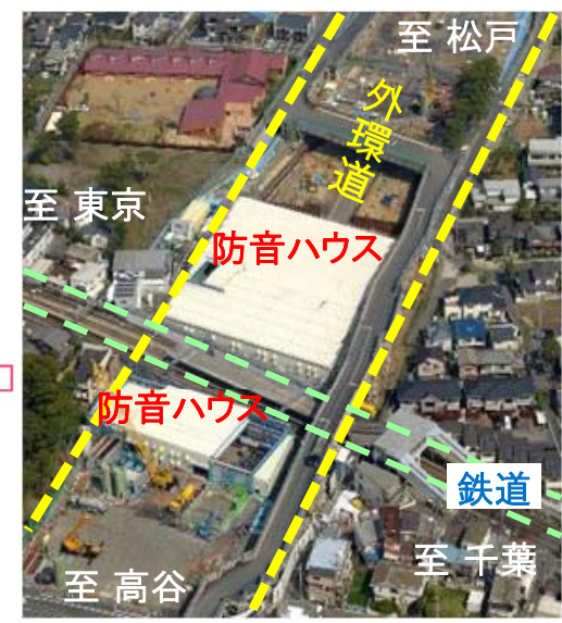
鉄道交差部付近の状況
